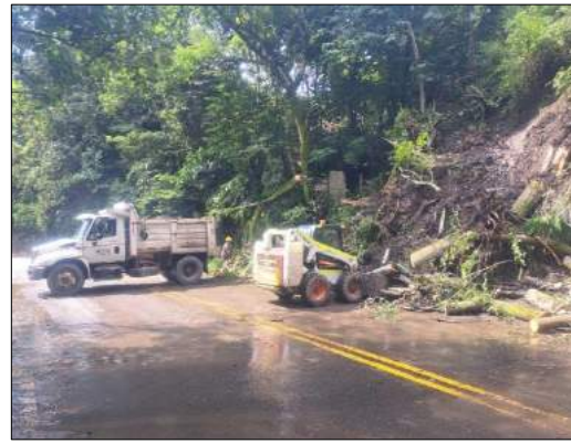
Foto 2. Remoción de derrumbes PR 70+5
