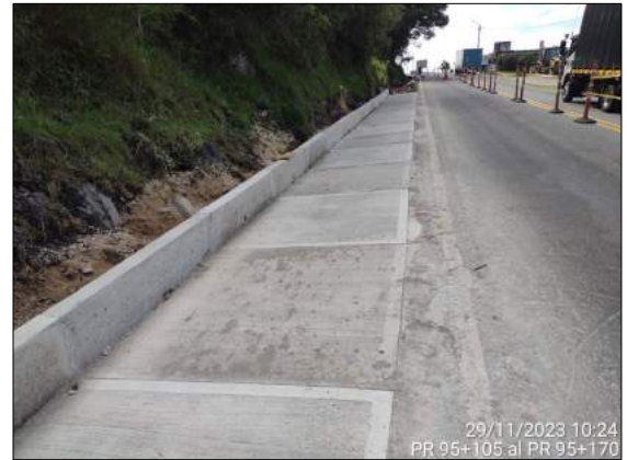
Foto 96. Reconstrucción de cuneta PR 95+105 al PR 95+150
