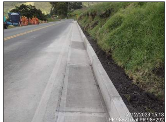
Foto 98. Reconstrucción de cuneta PR 98+210 al PR 98+292
