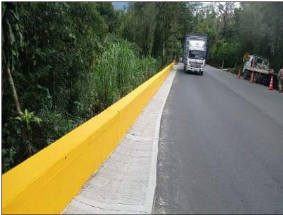
Foto 83. Reconstrucción de cuneta PR 82+085 al PR 82+135
