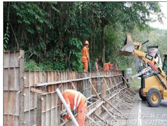
Foto 233. Recubrimiento de muro gavión PR52+368
