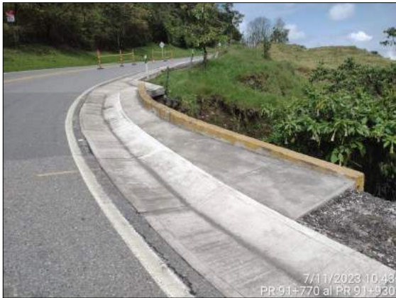
Foto 91. Reconstrucción de cuneta PR 91+770 al PR 91+930
