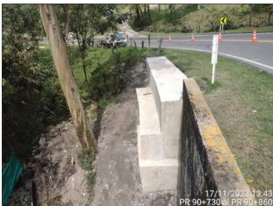
Foto 107. Revestimiento muro gavión PR 90+840
