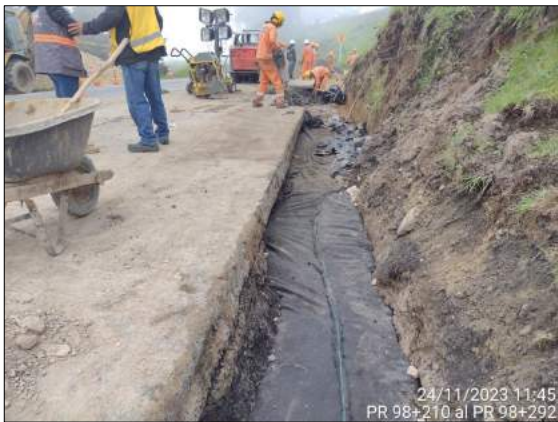
Foto 75. Reconstrucción de filtro PR 98+210 al PR 98+292
