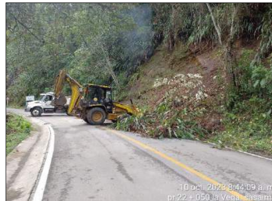
Foto 24. Remoción de derrumbes Sasaima – la Vega.
