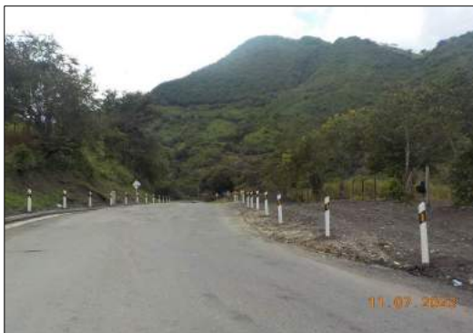
Foto 15. Reposición de hitos de arista PR 55+400
