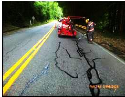
Foto 8. Sello fisuras PR 76+450 al PR 91+000
