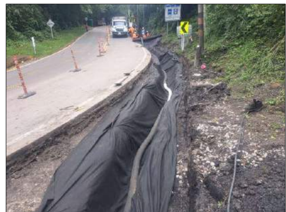
Foto 66. Reconstrucción de filtro PR 66+900 al PR 67+314
