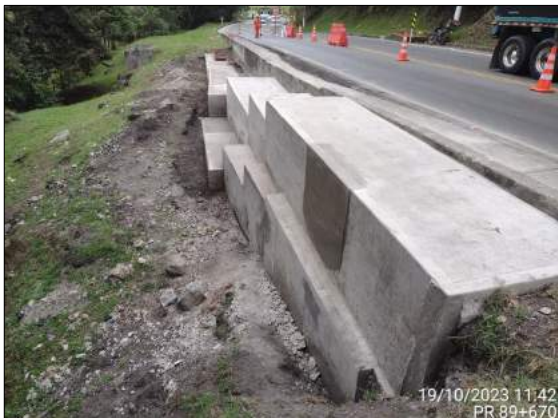
Foto 103. Revestimiento muro gavión PR 89+670
