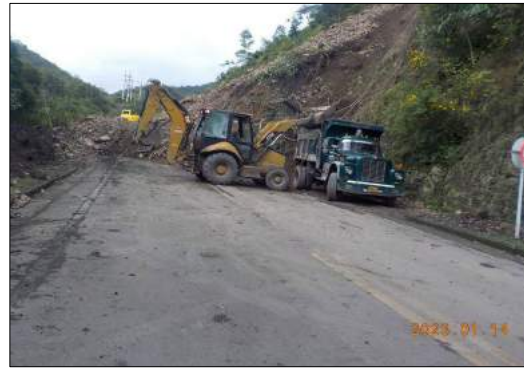
Foto 12. Remoción de derrumbes. PR 60+750
