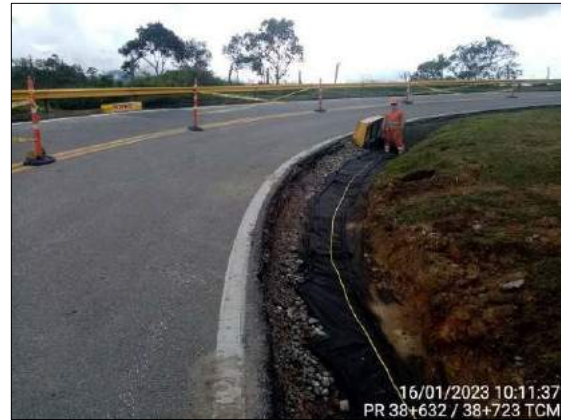
Foto 219. construcción de filtro PR38+632 AL PR38+723
