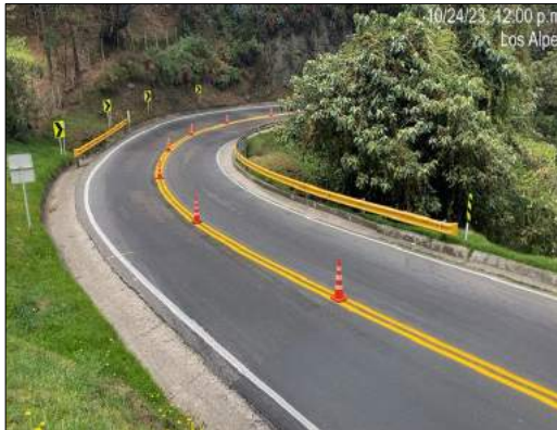
Foto 3. Demarcación horizontal en todo el tramo
