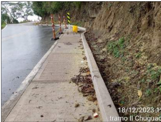
Foto 205. Reconstrucción de cunetas PR24+430 – PR24+473
