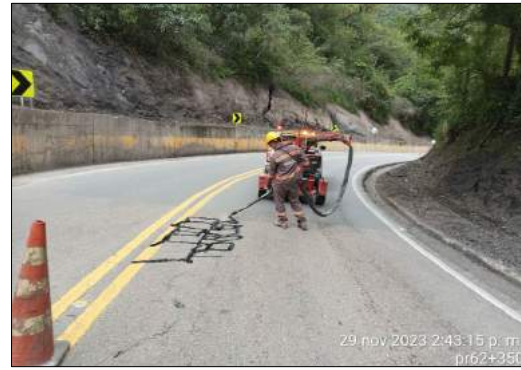
Foto 18. Sello fisuras PR 52+600 al PR 66+000.
