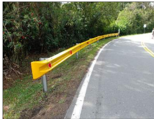
Foto 6. Reposición de defensas metálicas PR 82+450
