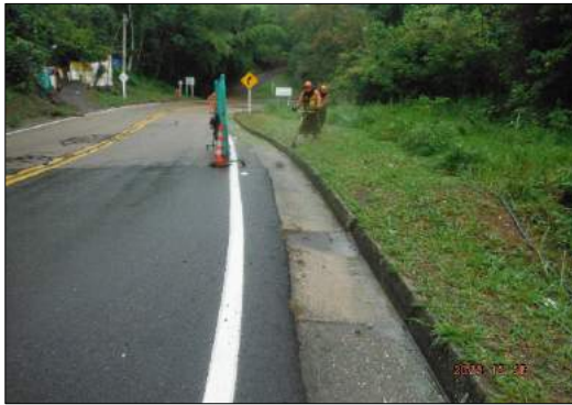
Foto 11. Rocería y desmonte PR 0+000 al PR 74+380.
