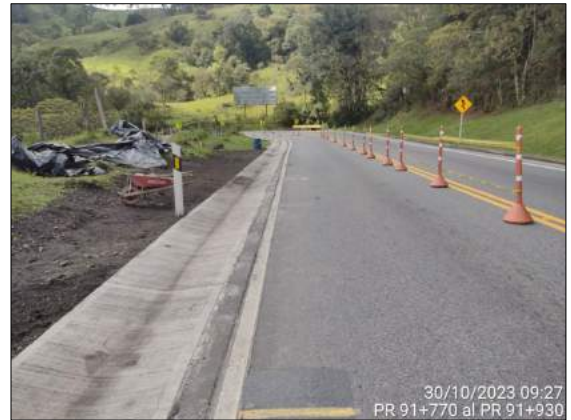
Foto 92. Reconstrucción de cuneta PR 91+770 al PR 91+930
