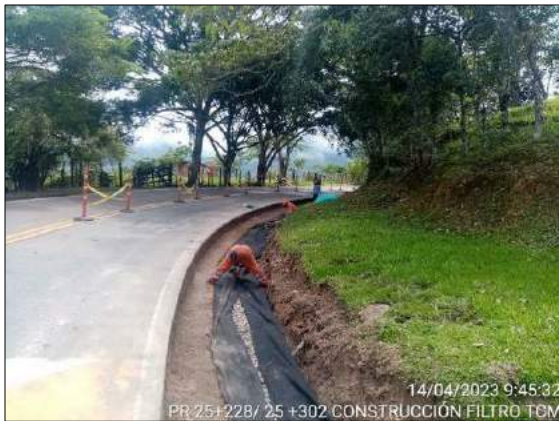
Foto 214. construcción de filtro PR25+228 AL PR25+302
