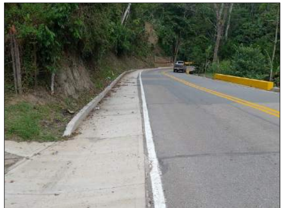
Foto 208. Reconstrucción cuneta PR38+190 – PR38+266
