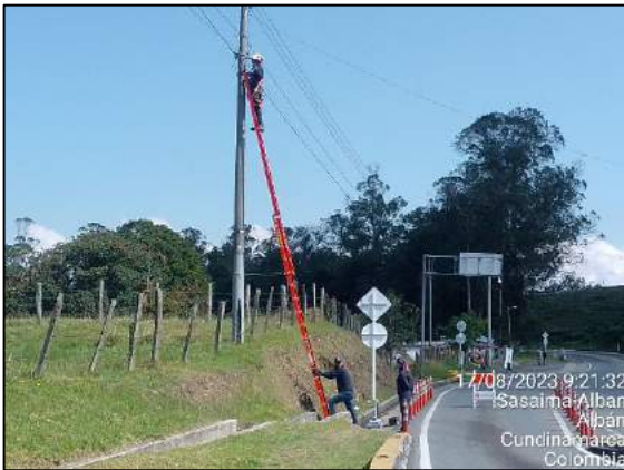
Foto 314. Labores de mantenimiento lamparas de iluminaciòn.
