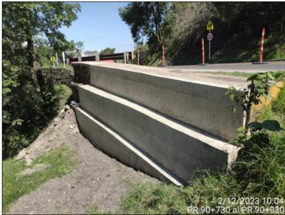
Foto 105. Revestimiento muro gavión PR 90+750
