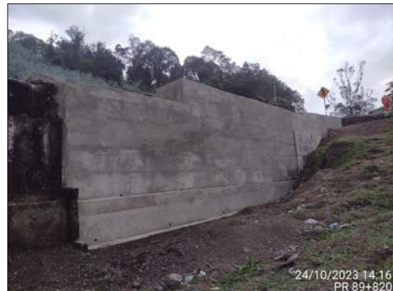
Foto 104. Revestimiento muro gavión PR 89+820
