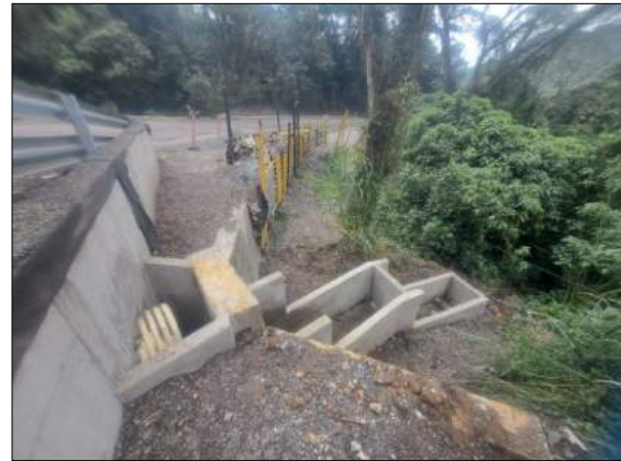
Foto 102. Reconstrucción de Alcantarilla 80+170
