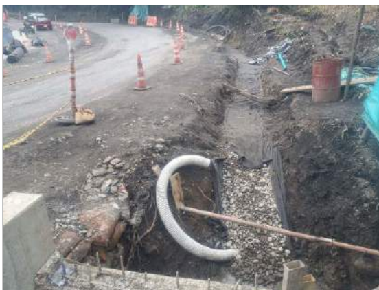
Foto 69. Reconstrucción de filtro PR 80+130 al PR 80+170
