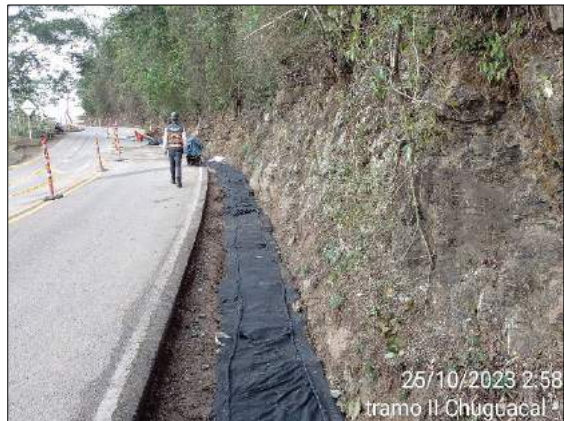
Foto 215. construcción de filtro PR24+354 AL PR24+430
