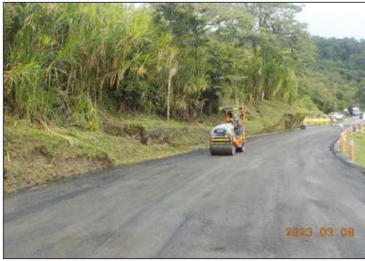
Foto 17. Renivelación con fresado cemento y emulsión PR 28+200.
