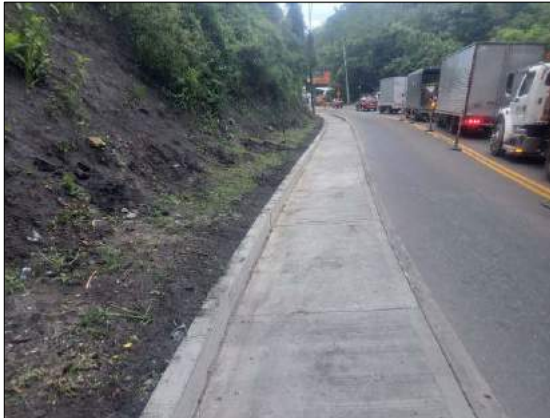
Foto 77. Reconstrucción de cuneta PR 66+900 al PR 67+314
