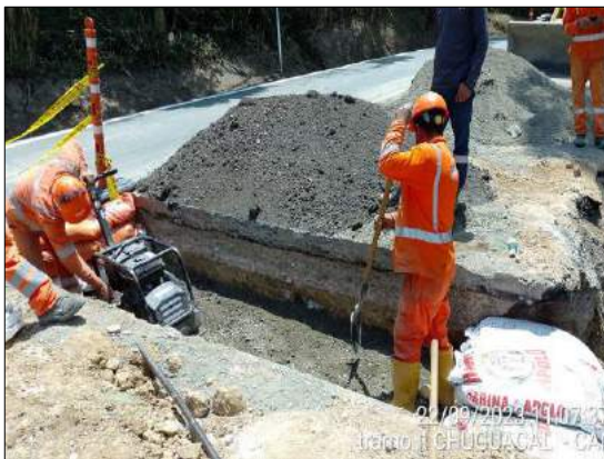
Foto 224. Reconstrucción de Alcantarilla 41+620
