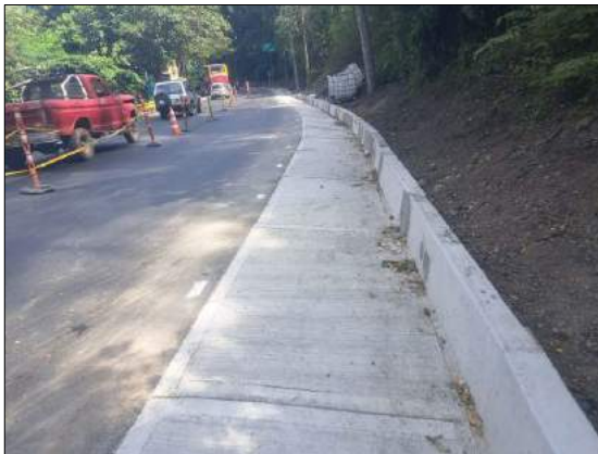
Foto 79. Reconstrucción de cuneta PR 66+900 al PR 67+314
