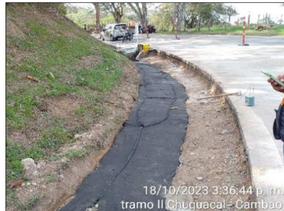
Foto 217. construcción de filtro PR25+302 AL PR25+391
