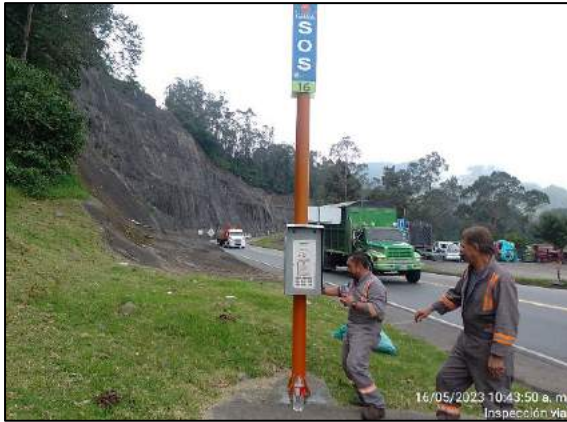
Foto 270. Cambio de láminas informativas postes S.O.S.
