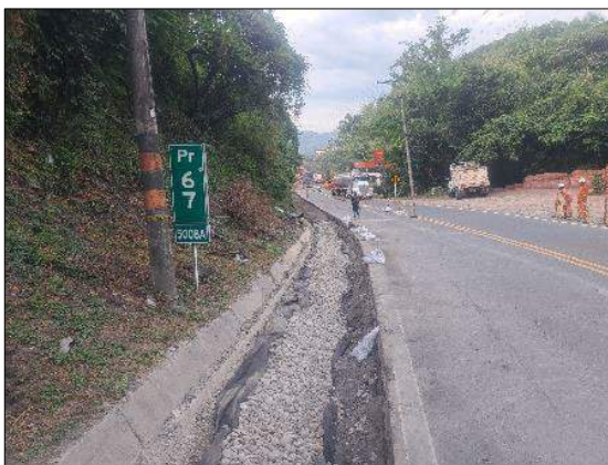
Foto 65. Reconstrucción de filtro PR 66+900 al PR 67+314
