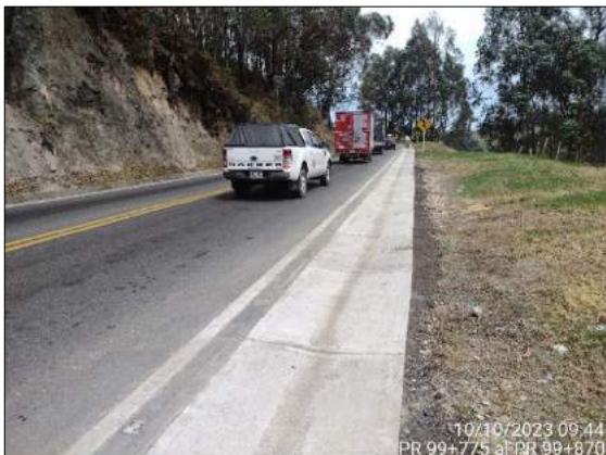
Foto 99. Reconstrucción de cuneta PR 99+775 al PR 99+870
