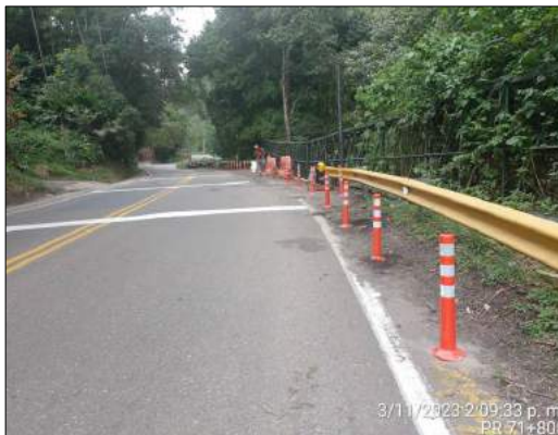
Foto 5. Reposición de hitos flexibles PR 71+800
