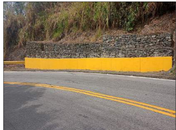
Foto 231. Recubrimiento de muro gavión PR51+440
