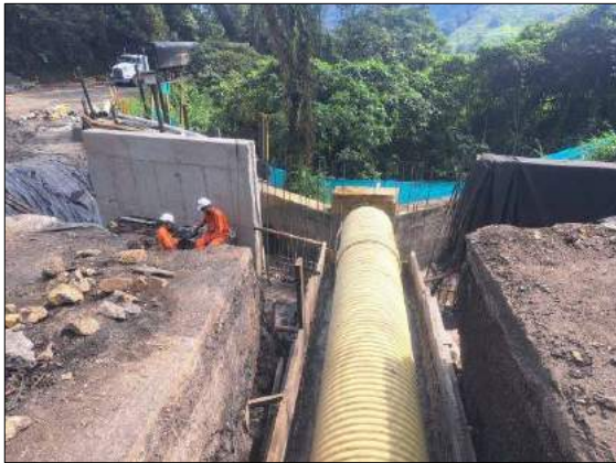
Foto 101. Reconstrucción de Alcantarilla 80+170
