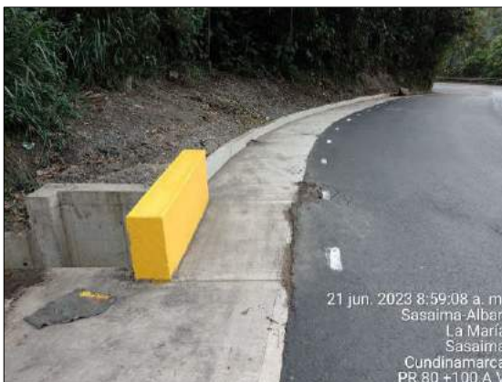
Foto 81. Reconstrucción de cuneta PR 80+100 al PR 80+170
