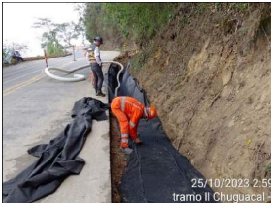
Foto 216. construcción de filtro PR24+430 AL PR24+473
