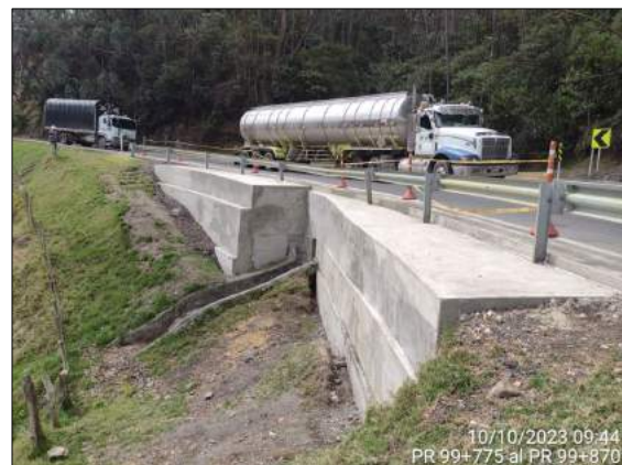
Foto 108. Revestimiento muro gavión PR 99+840
