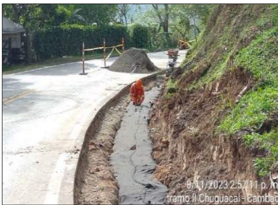
Foto 220. construcción de filtro PR26+600 AL PR26+744
