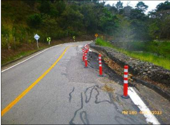
Foto 21. Reposición de hitos flexibles San Juan – Pulí.
