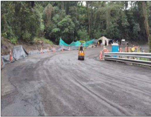
Foto 7. Renivelación con fresado cemento y emulsión PR 80+100
