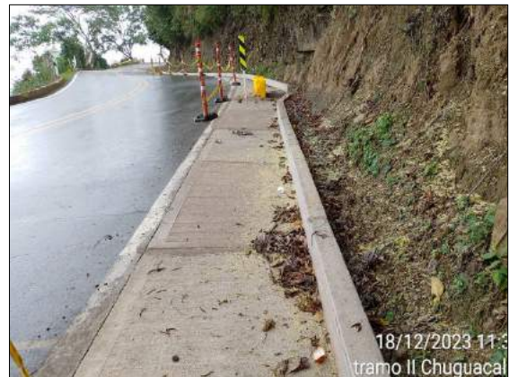
Foto 204. Reconstrucción de cunetas PR24+354 – PR24+430
