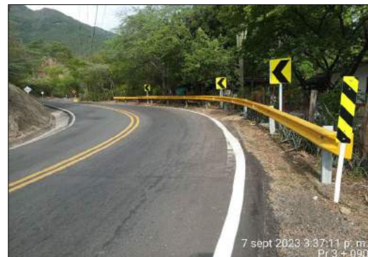
Foto 16. Reposición de defensas metálica PR 3+090
