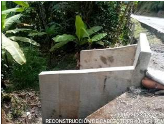
Foto 222. Reconstrucción de Alcantarilla 40+631
