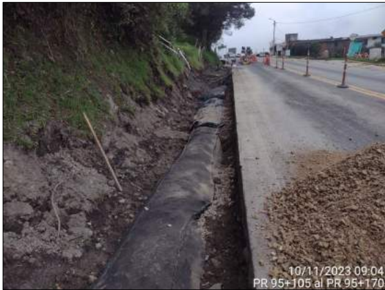
Foto 73. Reconstrucción de filtro PR 95+105 al PR 95+150
