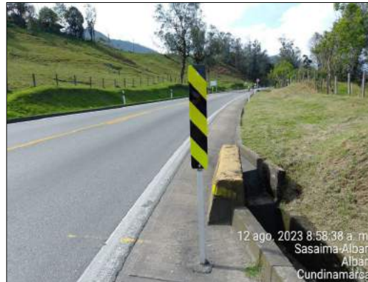
Foto 4. Instalación de señales verticales PR 92+810
