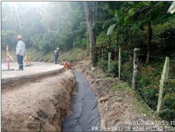
Foto 218. construcción de filtro PR38+190 AL PR38+266
