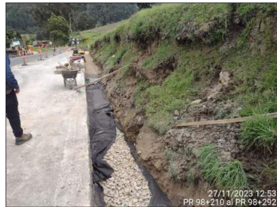
Foto 76. Reconstrucción de filtro PR 98+210 al PR 98+292
