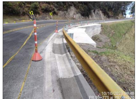
Foto 100. Reconstrucción de cuneta PR 99+775 al PR 99+870
