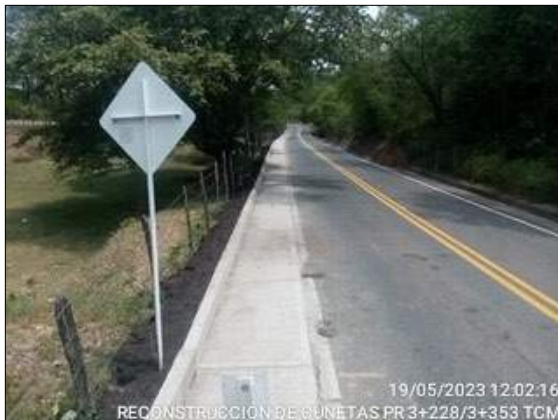
Foto 203. Reconstrucción de cunetas PR3+220 – PR3+353
