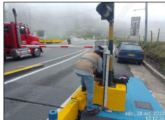
Foto 307. Mantenimiento preventivo talanqueras.
