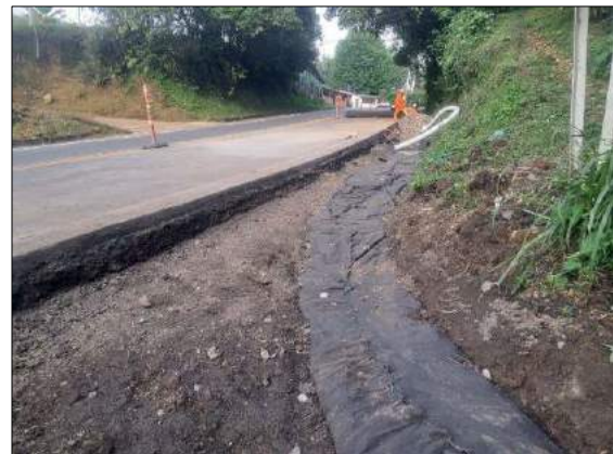
Foto 72. Reconstrucción de filtro PR 84+370 al PR 84+610
