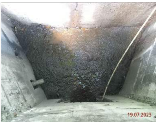
Foto 9. Limpieza de obras hidráulicas
