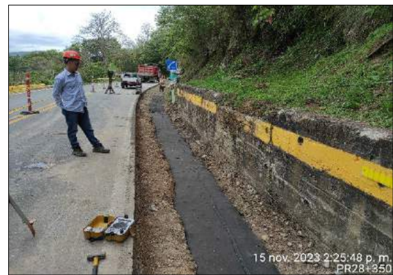
Foto 221. construcción de filtro PR28+420 AL PR28+503
