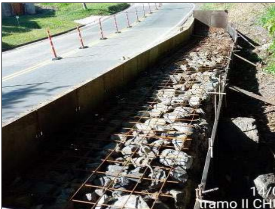
Foto 230. Recubrimiento de muro gavión PR39+776
