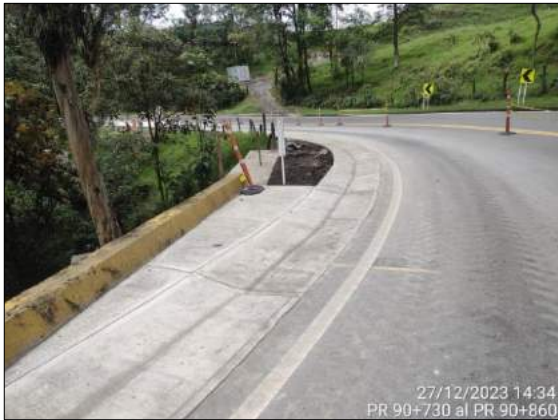
Foto 89. Reconstrucción de cuneta PR 90+730 al PR 90+860
