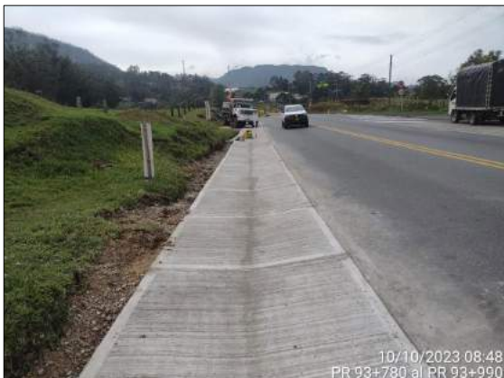
Foto 93. Reconstrucción de cuneta PR 93+780 al PR 93+990
