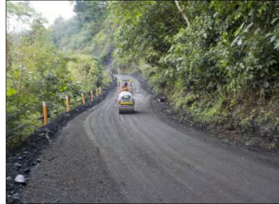
Foto 22. Renivelación con fresado cemento y emulsión Los Alpes – Quipile.
