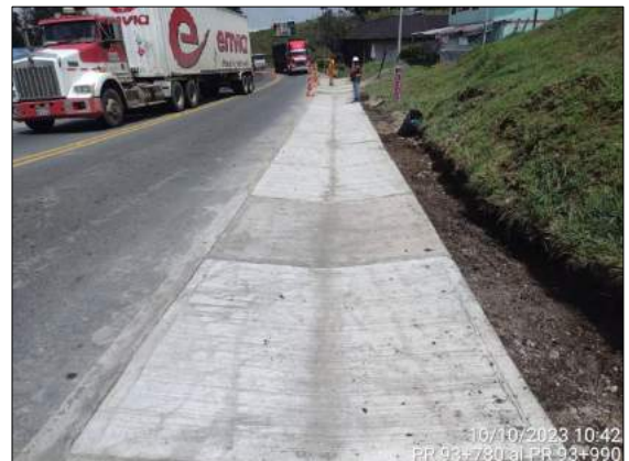
Foto 94. Reconstrucción de cuneta PR 93+780 al PR 93+990
