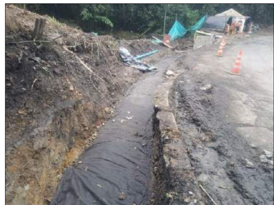
Foto 70. Reconstrucción de filtro PR 80+130 al PR 80+170
