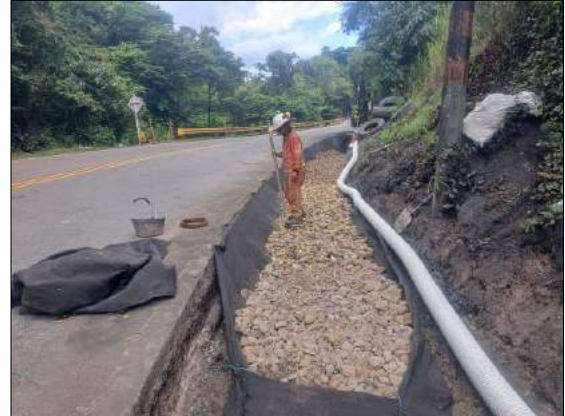
Foto 68. Reconstrucción de filtro PR 66+900 al PR 67+314
