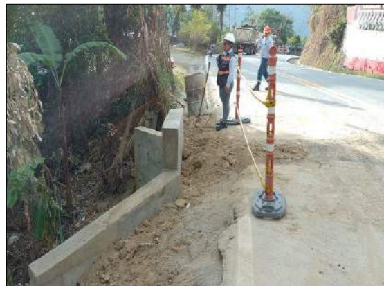
Foto 225. Reconstrucción de Alcantarilla 41+620
