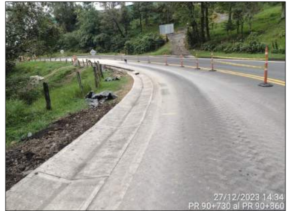
Foto 90. Reconstrucción de cuneta PR 90+730 al PR 90+860
