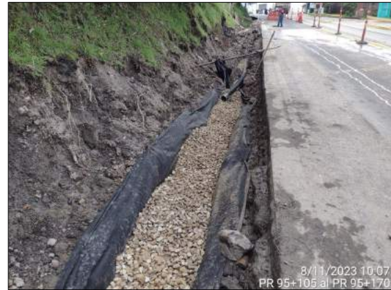
Foto 74. Reconstrucción de filtro PR 95+105 al PR 95+150
