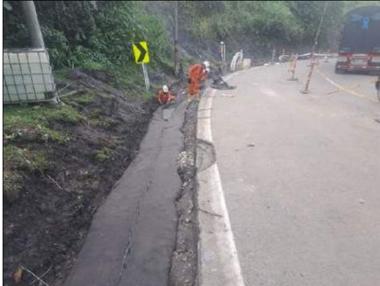
Foto 67. Reconstrucción de filtro PR 66+900 al PR 67+314
