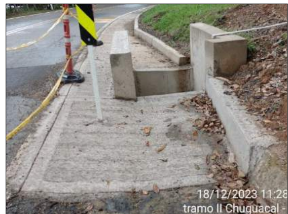
Foto 227. Reconstrucción de Alcantarilla 25+230
