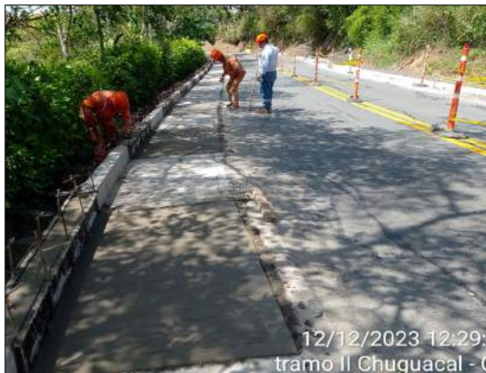
Foto 207. Reconstrucción cuneta PR26+600 – PR26+676
