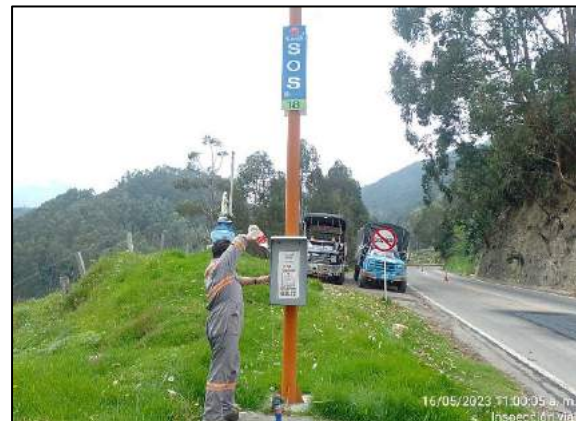
Foto 269. Cambio de láminas informativas postes S.O.S.
