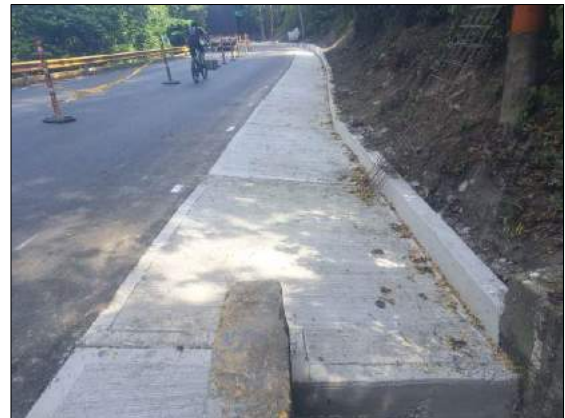
Foto 80. Reconstrucción de cuneta PR 66+900 al PR 67+314
