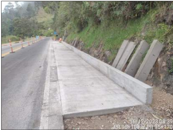
Foto 95. Reconstrucción de cuneta PR 95+105 al PR 95+150
