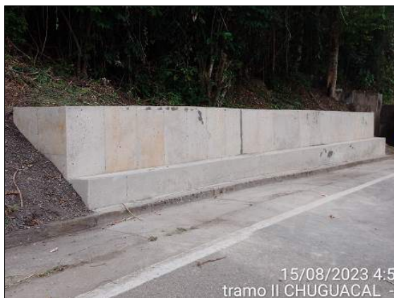
Foto 235. Recubrimiento de muro gavión PR52+398
