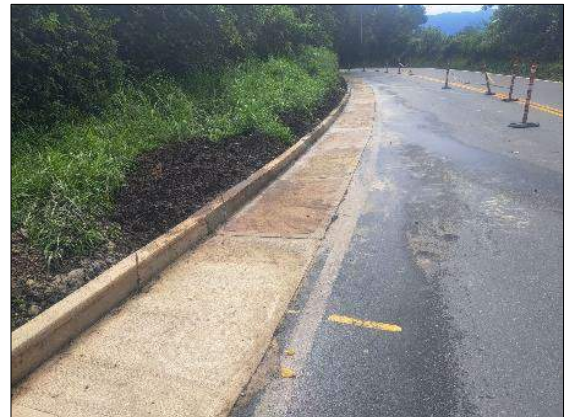
Foto 88. Reconstrucción de cuneta PR 84+605 al PR 84+736
