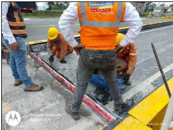
Foto 296. Trabajos de mantenimiento de juntas realizados en la báscula los alpes -villeta
