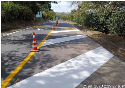
Foto 13. Demarcación horizontal en todo el tramo.
