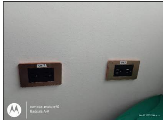
Foto 313. Instación de tomas e interruptores.
