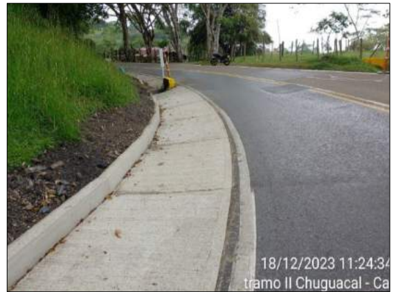
Foto 206. Reconstrucción de cunetas PR25+302 – PR25+391
