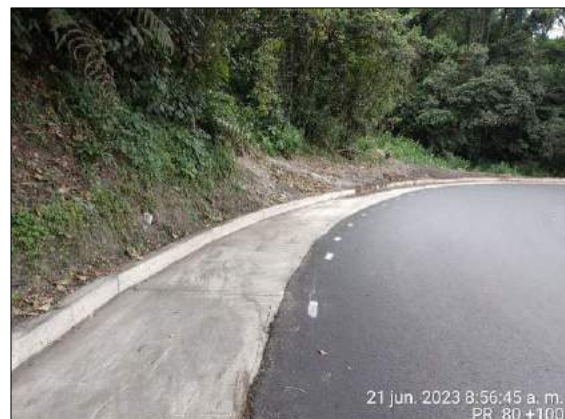
Foto 82. Reconstrucción de cuneta PR 80+100 al PR 80+170
