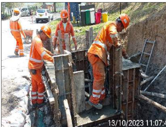
Foto 226. Reconstrucción de Alcantarilla 25+230
