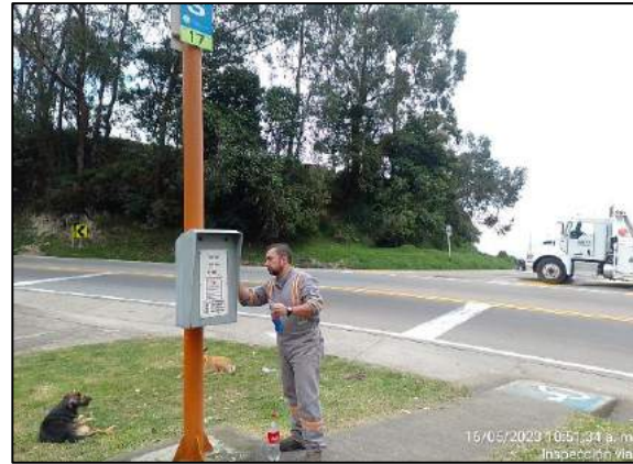
Foto 271. Cambio de láminas informativas postes S.O.S.
