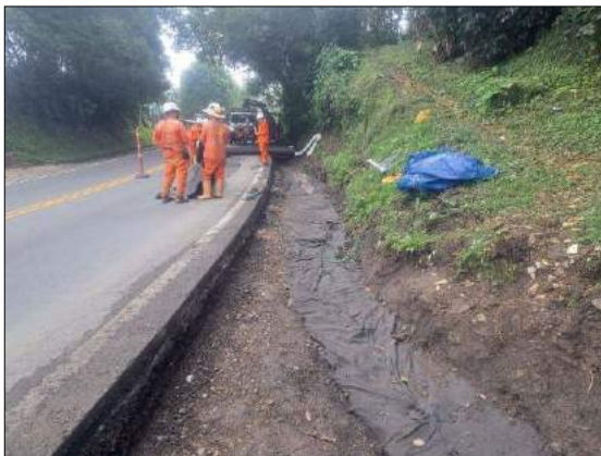
Foto 71. Reconstrucción de filtro PR 84+370 al PR 84+610
