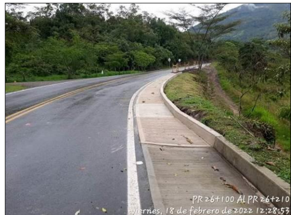
Foto 54. Reconstrucción de cunetas PR26+113 – PR26+210
