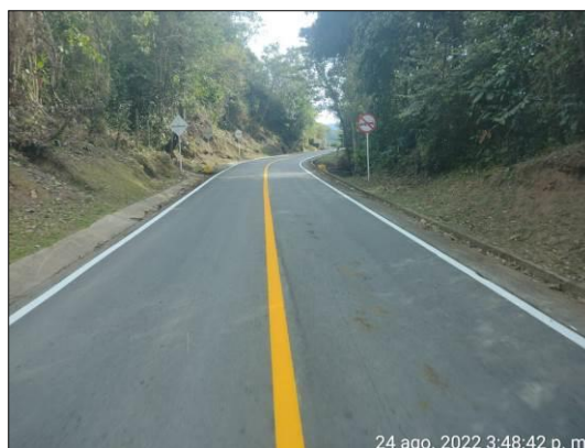
Foto 12. Demarcación horizontal del tramo vial San vicente - chaguani.
