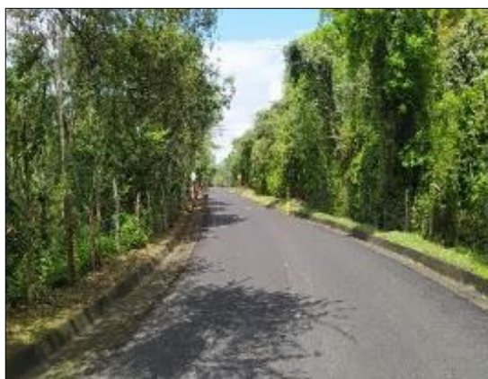
Foto 46. Slurry PR2+500
