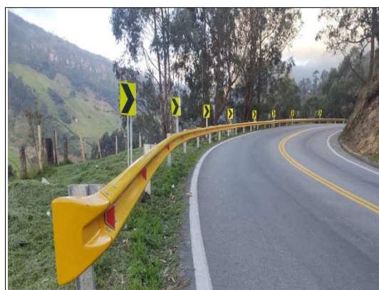
Foto 2. Instalación de barandas metálicas PR 99+750
