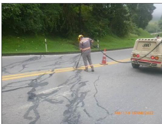
Foto 1. Sello de fisuras PR 68+630 AL PR 92+450
