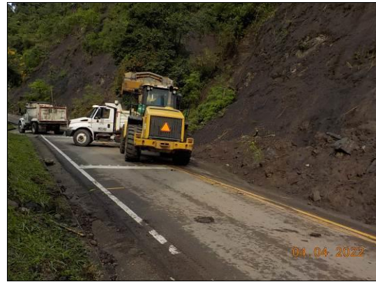
Foto 6. Remoción de derrumbes. PR 57+200
