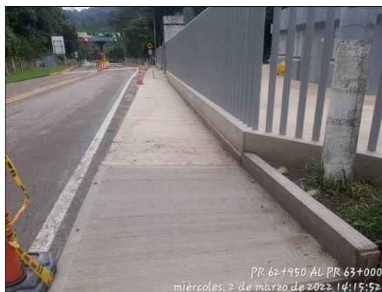
Foto 64. Reconstrucción cuneta PR62+900 – PR63+000
