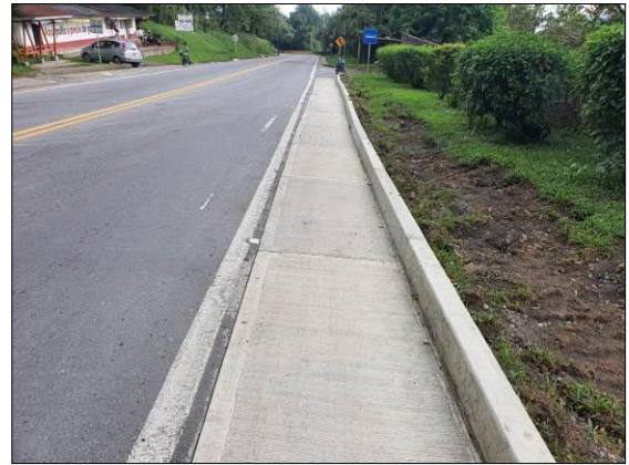
Foto 38. Reconstrucción de cunetas PR 85+145 al PR 85+235
