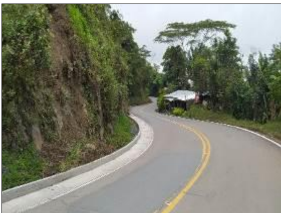
Foto 57. Reconstrucción cuneta PR29+730 – PR34+546
