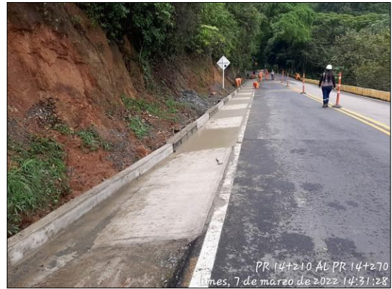
Foto 52. Reconstrucción cuneta PR14+210 – PR14+270
