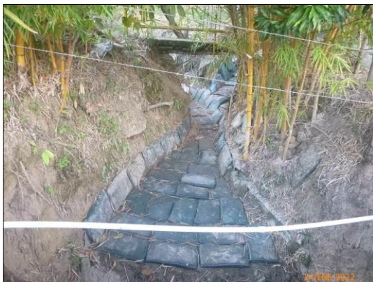
Foto 9. Reconstrucción de canal en sacos de suelo cemento San Juan – Puli.
