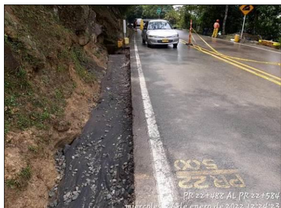
Foto 68. construcción de filtro PR22+488 AL PR22+584
