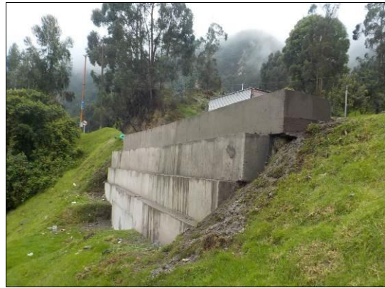
Foto 4. Revestimiento de muro gavión PR 100+360
