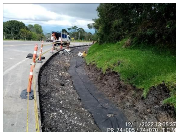
Foto 70. construcción de filtro PR73+955 AL PR74+244
