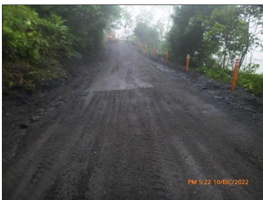
Foto 11. Renivelación con fresado cemento y emulsión Los Alpes - Quipile.
