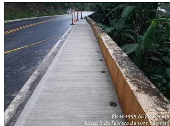
Foto 56. Reconstrucción de cunetas PR30+595 – PR30+615
