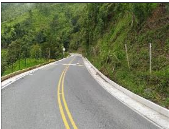
Foto 61. Reconstrucción de cunetas PR29+730 – PR34+546
