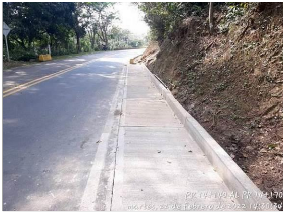
Foto 51. Reconstrucción cuneta PR14+140 – PR14+170
