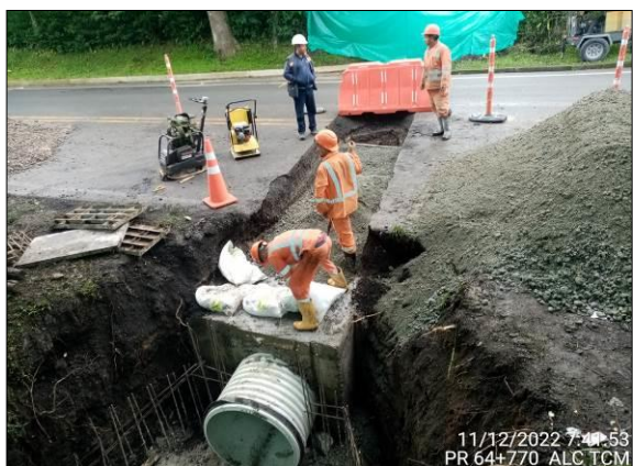
Foto 71. Reconstrucción de Alcantarilla 64+770
