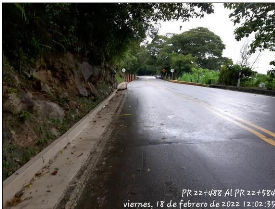
Foto 53. Reconstrucción de cunetas PR22+488 – PR22+584
