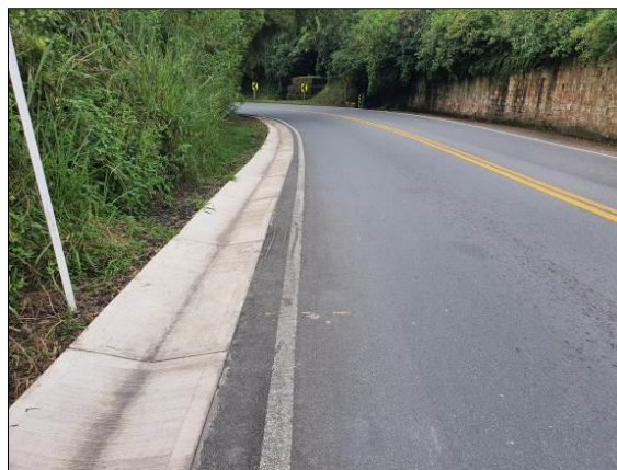
Foto 34. Reconstrucción de cunetas PR 83+503 al PR 85+565
