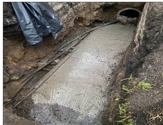
Foto 40. Reconstrucción de Alcantarilla 80+130
