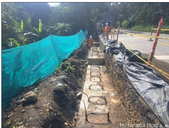
Foto 41. Construcción de muro de confinamiento PR 82+085 al PR 82+135
