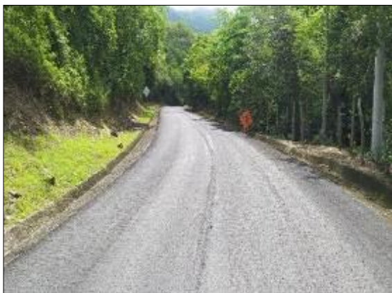
Foto 45. Slurry PR2+500
