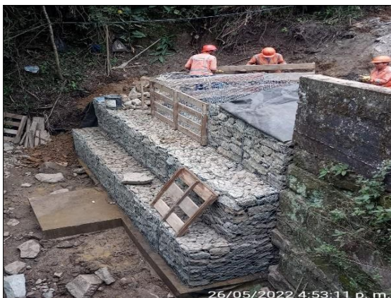
Foto 75. Reconstrucción de muro gavión PR 38+050 al PR 38+070
