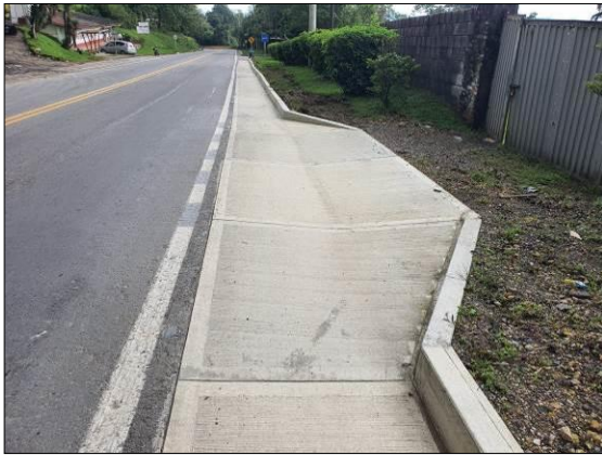
Foto 37. Reconstrucción de cunetas PR 85+145 al PR 85+235
