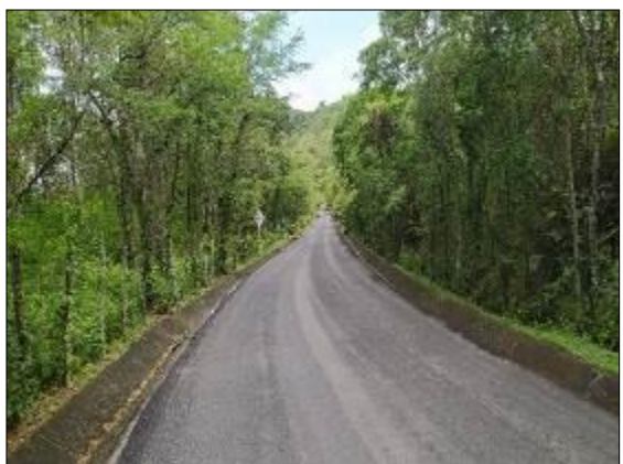
Foto 49. Slurry PR4+100
