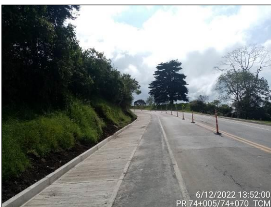
Foto 66. Reconstrucción cuneta PR73+955 – PR74+244
