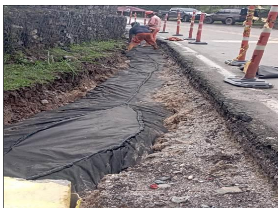
Foto 69. construcción de filtro PR48+095 AL PR48+177
