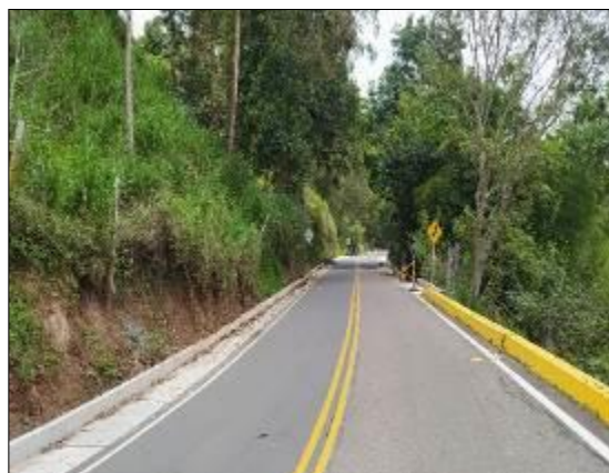
Foto 62. Reconstrucción de cunetas PR29+730 – PR34+546
