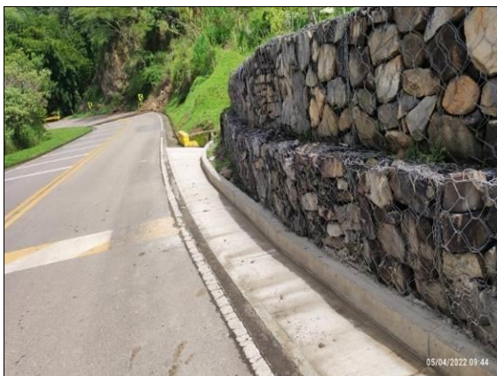
Foto 63. Reconstrucción cuneta PR48+095 – PR48+177
