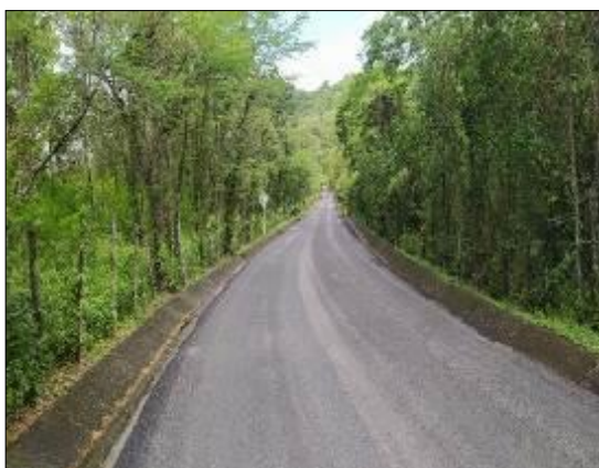
Foto 48. Slurry PR3+600
