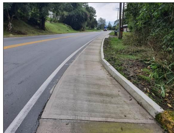
Foto 36. Reconstrucción de cunetas PR 84+845 al PR 84+960
