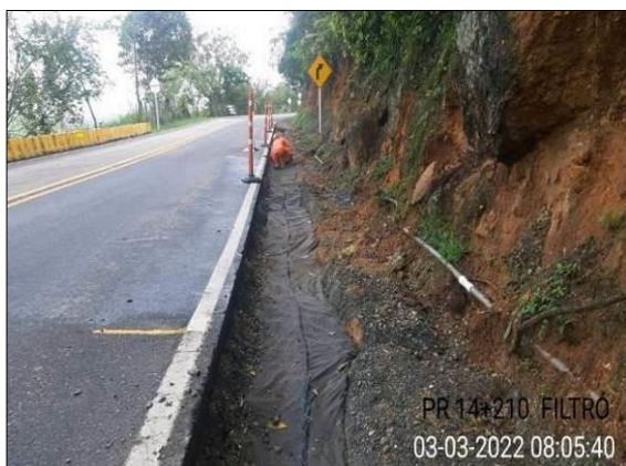
Foto 67. construcción de filtro PR14+210 AL PR14+270
