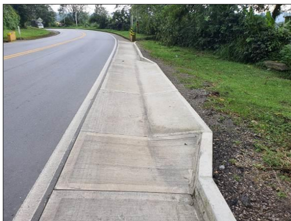
Foto 35. Reconstrucción de cunetas PR 84+845 al PR 84+960
