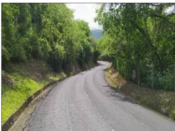
Foto 47. Slurry PR3+200
