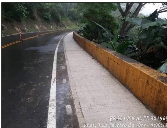
Foto 55. Reconstrucción de cunetas PR30+482 – PR30+615
