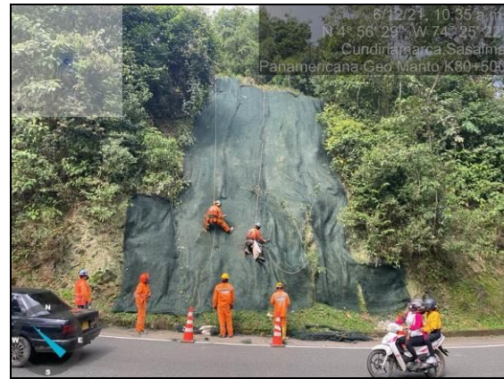
Foto 180. Instalación Geomanto talud PR 80+600 (LA-V)
