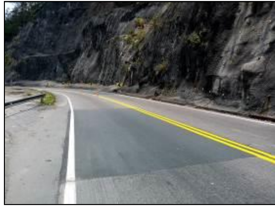
Foto 16. Parcheo con mezcla asfáltica PR96+510 al PR96+798
