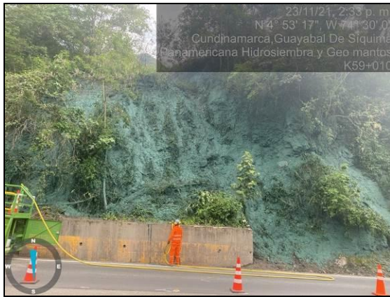
Foto 173. Hidrosiembra talud PR 59+010 (CH-C)
