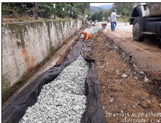
Foto 63 Construcción de filtro PR 67+215 al PR 67+285
