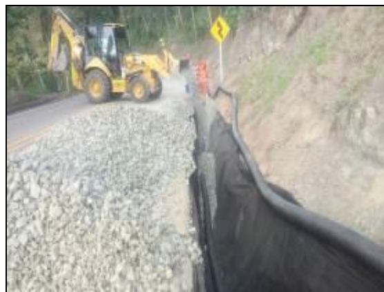
Foto 59 construcción de filtro K36+100 AL K40+000
