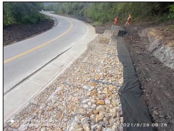
Foto 74 Reconstrucción de muro gavión PR 54+550 al PR 54+590
