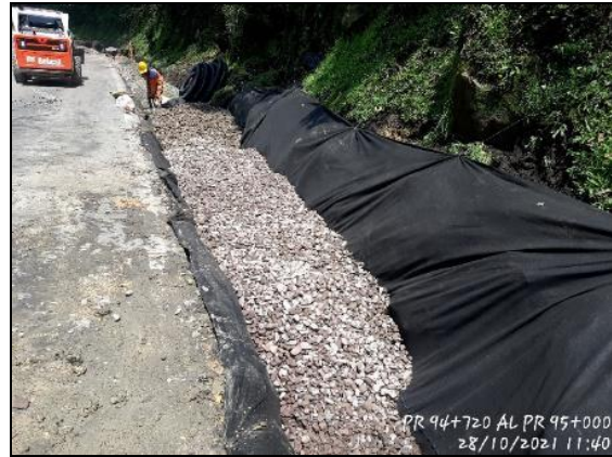
Foto 24 Construcción de filtro PR 94+730 al PR 95+015
