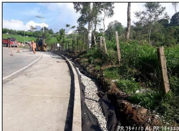
Foto 66 Construcción de filtro PR 73+110 al PR 73+220
