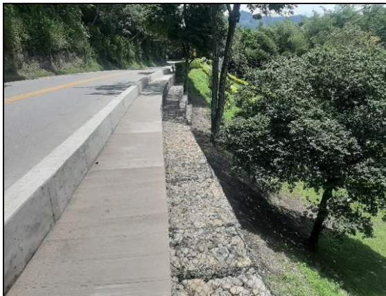
Foto 25 Revestimiento de muro de gavión PR 77+700 al PR 77+730
