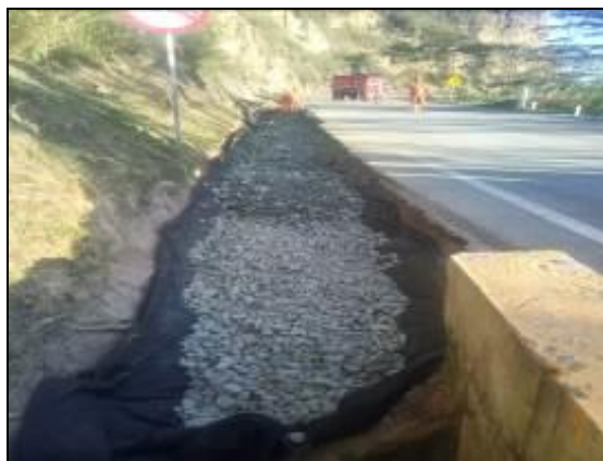
Foto 60 construcción de filtro K36+100 AL K40+000
