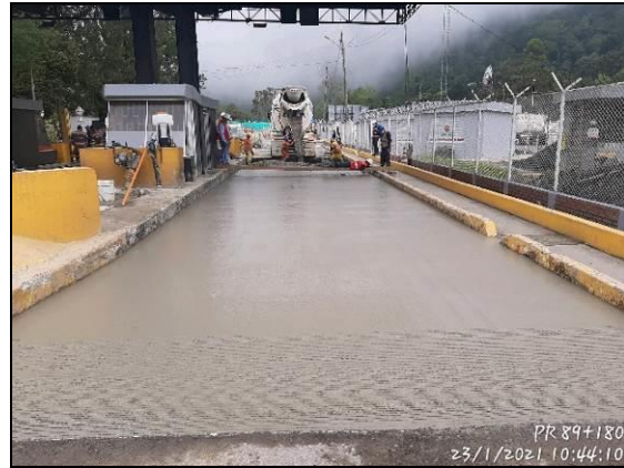
Foto 32 Reconstrucción losas peaje PR 89+180
