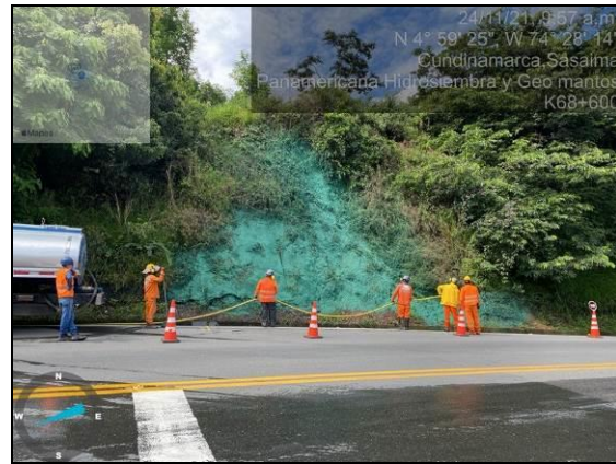
Foto 174. Hidrosiembra talud PR 68+600 (LA-V)
