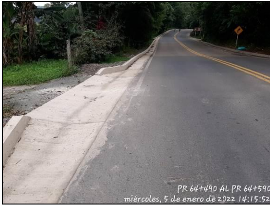
Foto 55 Reconstrucción de cunetas PR 64+490 al PR 64+590
