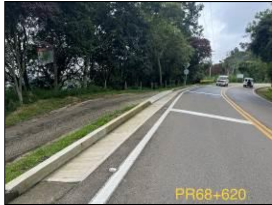
Foto 50. Reconstrucción de cunetas PR 68+620
