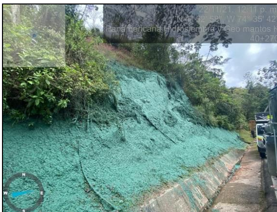
Foto 171. Hidrosiembra talud PR 40+270 (CH-C)
