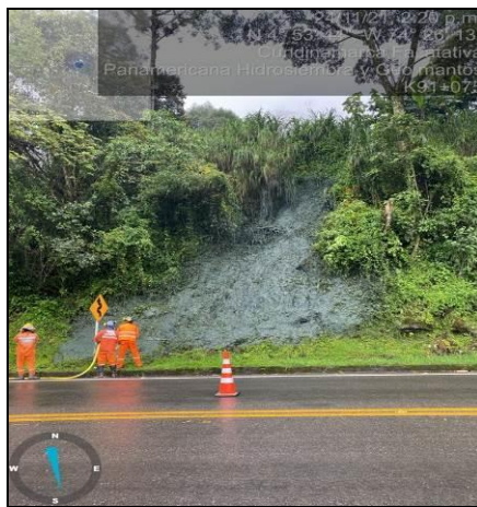
Foto 175. Hidrosiembra talud PR 91+075 (LA-V)
