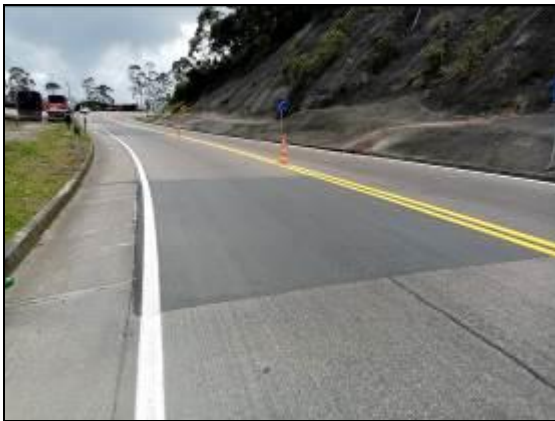
Foto 17. Parcheo con mezcla asfáltica PR96+510 al PR96+798
