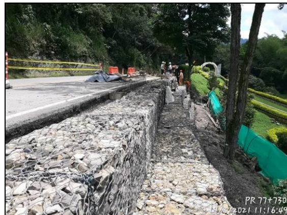
Foto 30 Reconstrucción de muro de gavión PR 77+700 al PR 77+730
