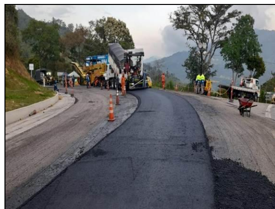
Foto 41. Carpeta Asfáltica del PR29+555 al PR38+850
