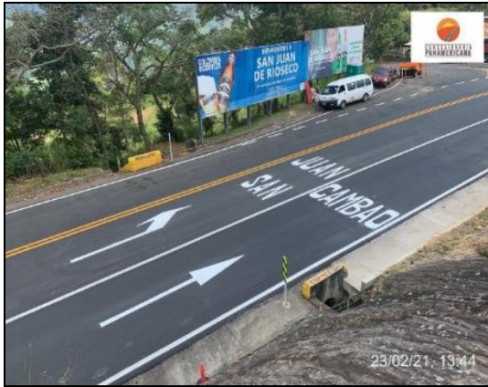
Foto 5. Demarcación horizontal en todo el tramo.
