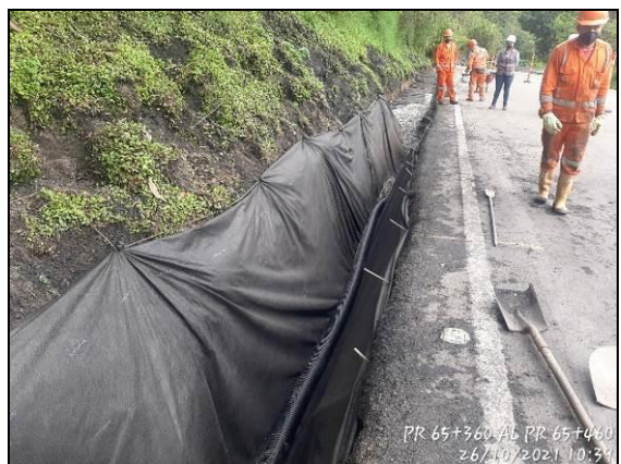
Foto 64 Construcción de filtro PR 65+360 al PR 65+460
