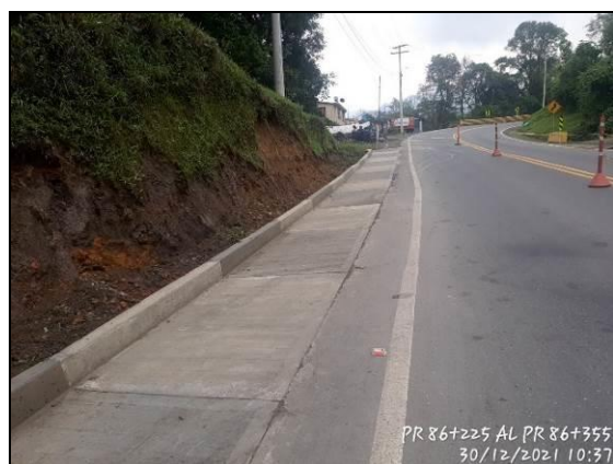
Foto 21 Reconstrucción de cunetas PR 86+225 al PR 86+355
