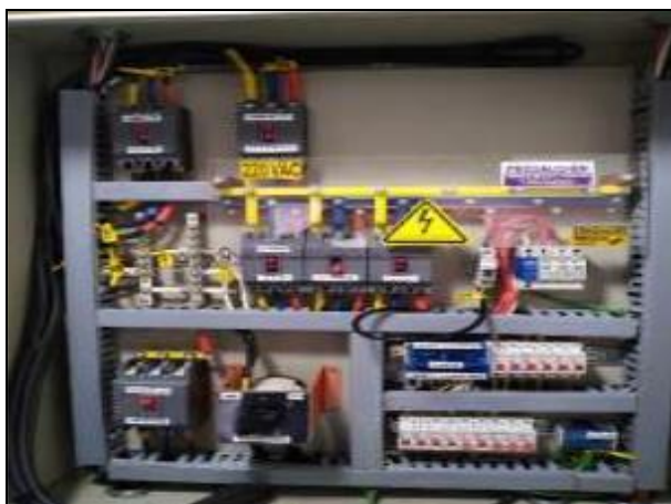
Foto 193. Parcial eléctrica hacia la UPS
