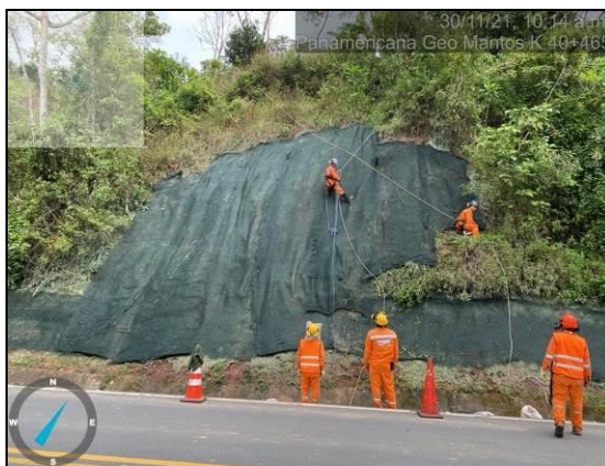
Foto 177. Instalación Geomanto talud PR 40+465 (Ch-C)
