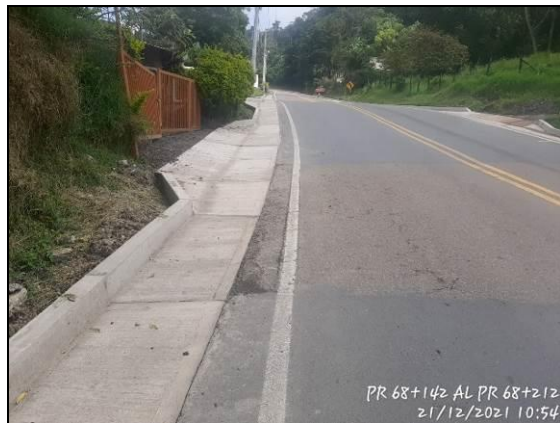
Foto 54 Reconstrucción de cunetas PR 68+142 al PR 68+212
