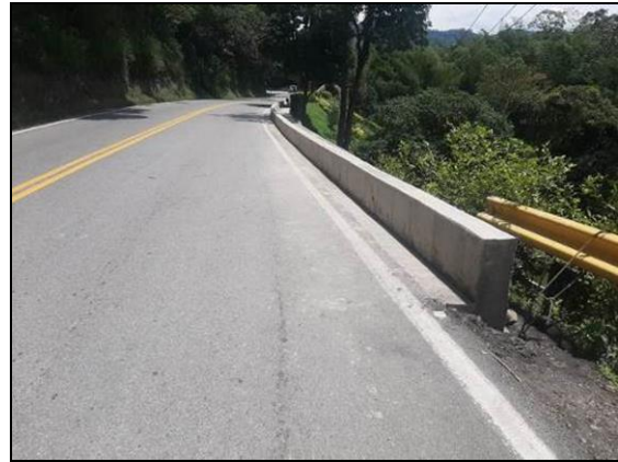
Foto 28 Construcción de muro de confinamiento PR 77+700 al PR 77+730
