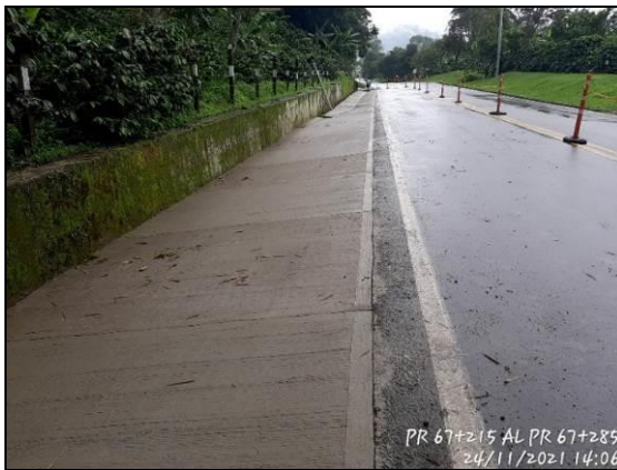
Foto 51 Reconstrucción de cunetas PR 67+215 al PR 67+285
