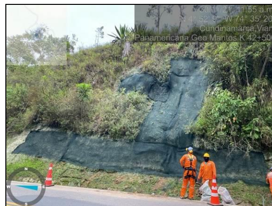
Foto 178. Instalación Geomanto talud PR 42+500 (Ch-C)
