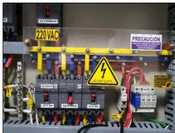
Foto 194. Protecciones de distribución
