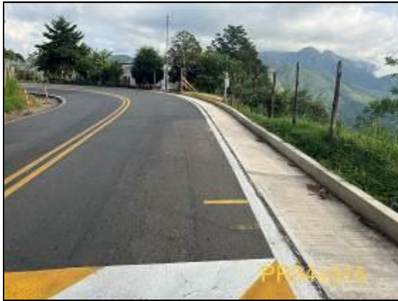
Foto 49. Reconstrucción de cunetas PR 44+070
