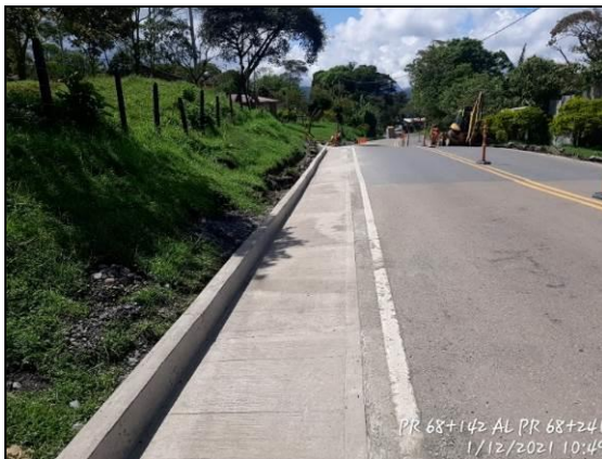
Foto 53 Reconstrucción de cunetas PR 68+142 al PR 68+212
