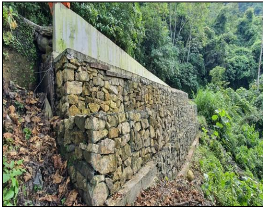
Foto 9. Reconstrucción muro en gaviones Sasaima – La Vega.
