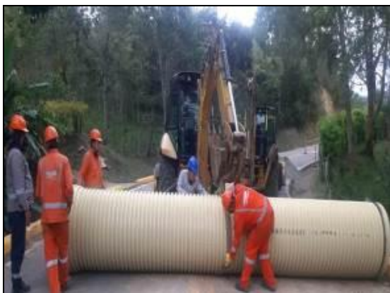
Foto 67 Reconstrucción de Alcantarilla 35+489
