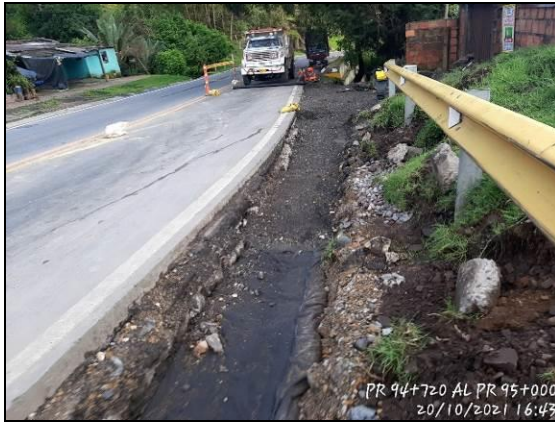
Foto 23 Construcción de filtro PR 94+730 al PR 95+015
