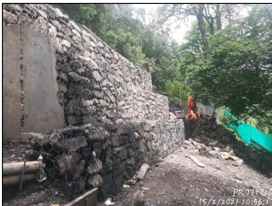
Foto 29 Reconstrucción de muro de gavión PR 77+700 al PR 77+730
