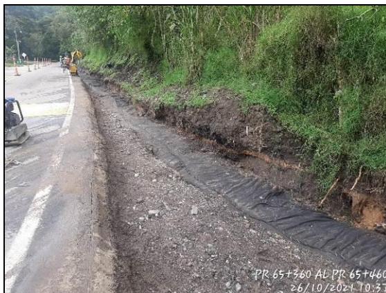
Foto 65 Construcción de filtro PR 65+360 al PR 65+460
