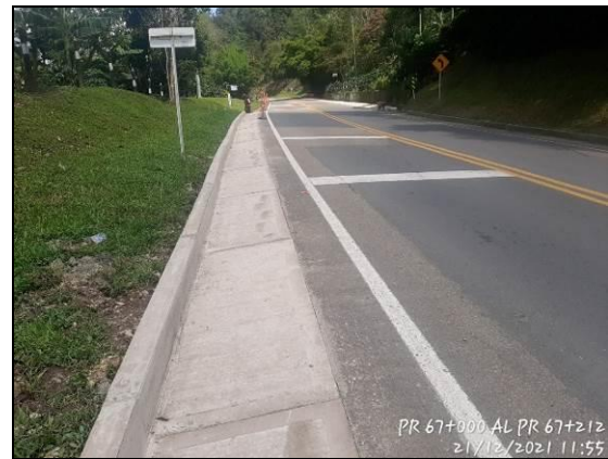
Foto 52 Reconstrucción de cunetas PR 67+120 al PR 67+212
