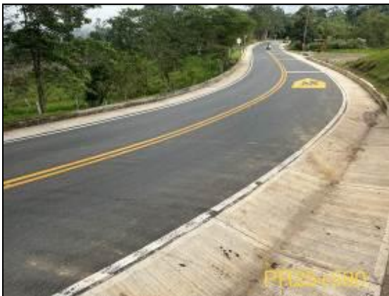
Foto 45. Reconstrucción cuneta PR25+590
