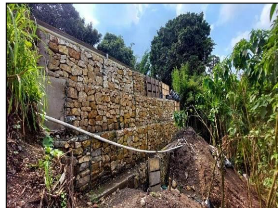
Foto 4. Construcción muro de gaviones PR 82+950
