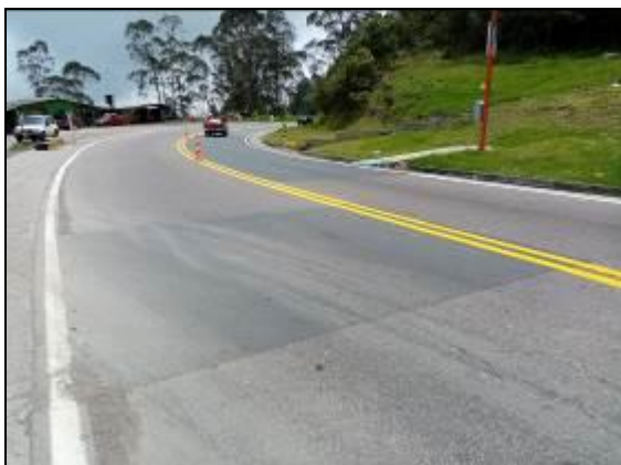
Foto 13. Parcheo con mezcla asfáltica PR96+510 al PR96+798
