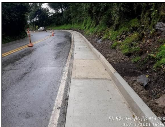
Foto 19 Reconstrucción de cunetas PR 94+730 al PR 95+015
