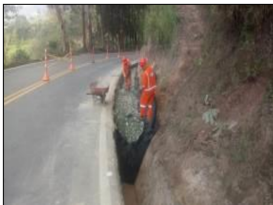
Foto 57 construcción de filtro K36+100 AL K40+000
