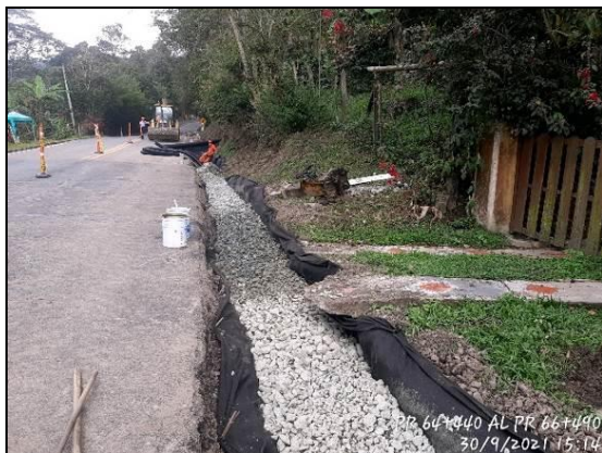
Foto 61 Construcción de filtro PR 64+490 al PR 64+590
