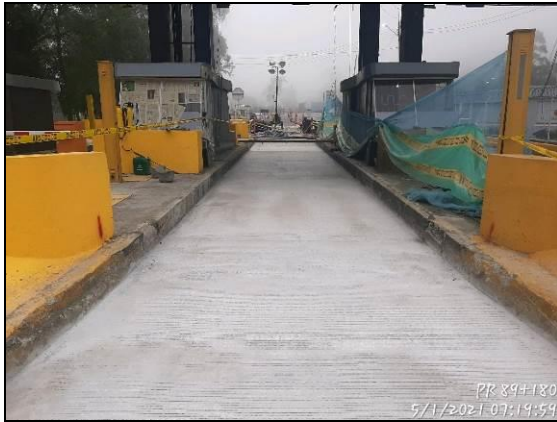
Foto 31 Reconstrucción losas peaje PR 89+180
