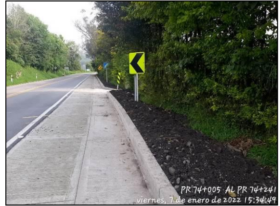
Foto 56 Reconstrucción de cunetas PR 74+005 al PR 74+241
