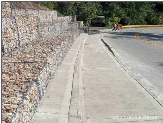
Foto 73 Reconstrucción de muro gavión PR 54+550 al PR 54+590
