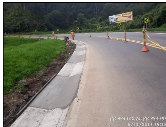
Foto 20 Reconstrucción de cunetas PR 99+180 al PR 99+356
