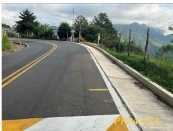
Foto 47. Reconstrucción de cunetas PR 34+315
