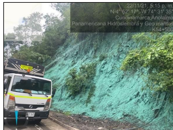
Foto 172. Hidrosiembra talud PR 54+500 (CH-C)
