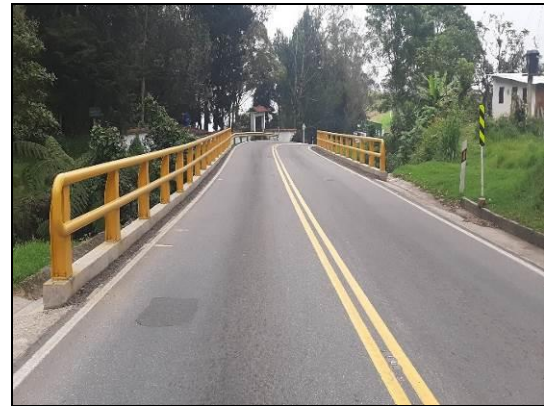
Foto 2. Instalación de barandas metálicas PR 93+610
