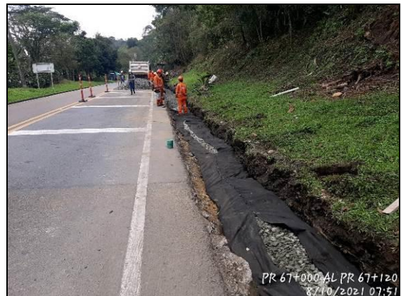
Foto 62 Construcción de filtro PR 67+000 al PR 67+120
