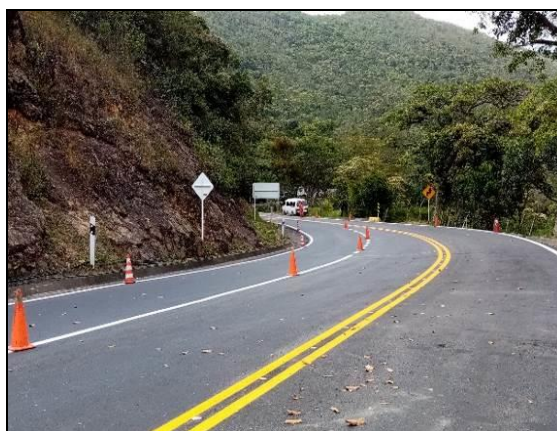
Foto 44. Carpeta Asfáltica del PR29+555 al PR38+850
