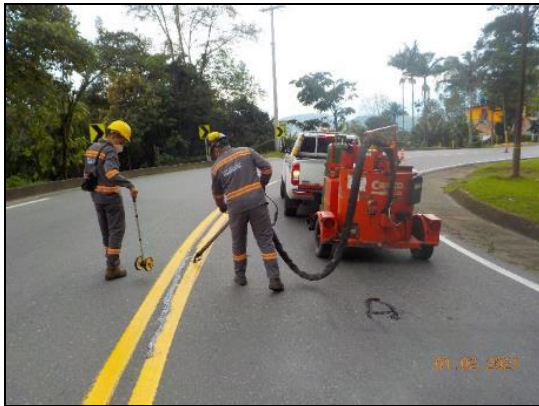
Foto 1. Sello de fisuras en todo el tramo
