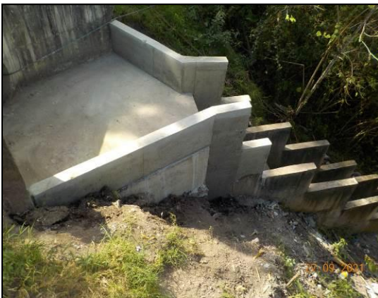
Foto 11. Reconstrucción de canal disipador Tabacal – La Sierra.
