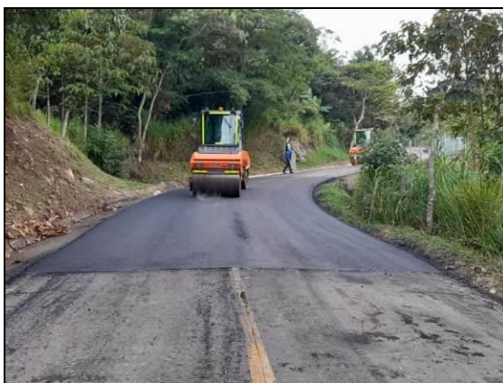
Foto 42. Carpeta Asfáltica del PR29+555 al PR38+850
