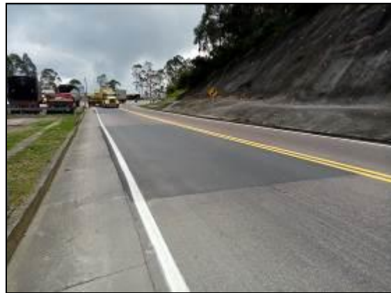
Foto 18. Parcheo con mezcla asfáltica PR96+510 al PR96+798
