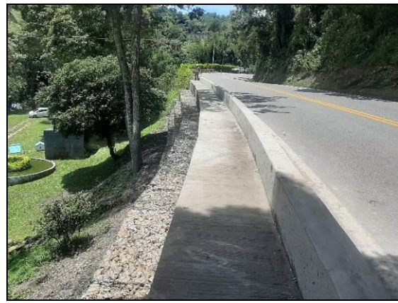
Foto 26 Revestimiento de muro de gavión PR 77+700 al PR 77+730
