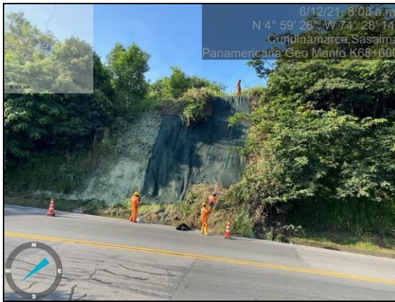
Foto 179. Instalación Geomanto talud PR 68+600 (LA-V)
