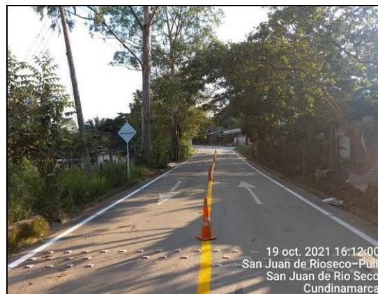
Foto 12. Demarcación horizontal del tramo vial San Juan de Rioseco – Puli.
