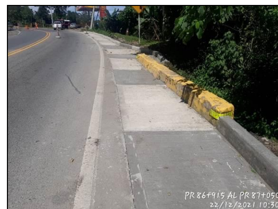
Foto 22 Reconstrucción de cunetas PR 86+915 al PR 87+050
