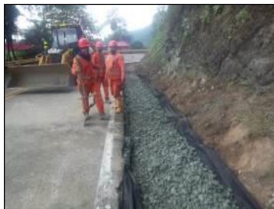
Foto 58 construcción de filtro K36+100 AL K40+000
