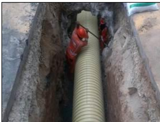
Foto 68 Reconstrucción de Alcantarilla 35+489
